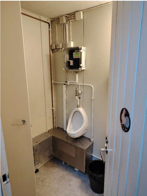
Sisä WC:t rakennettiin vuonna 1972.
