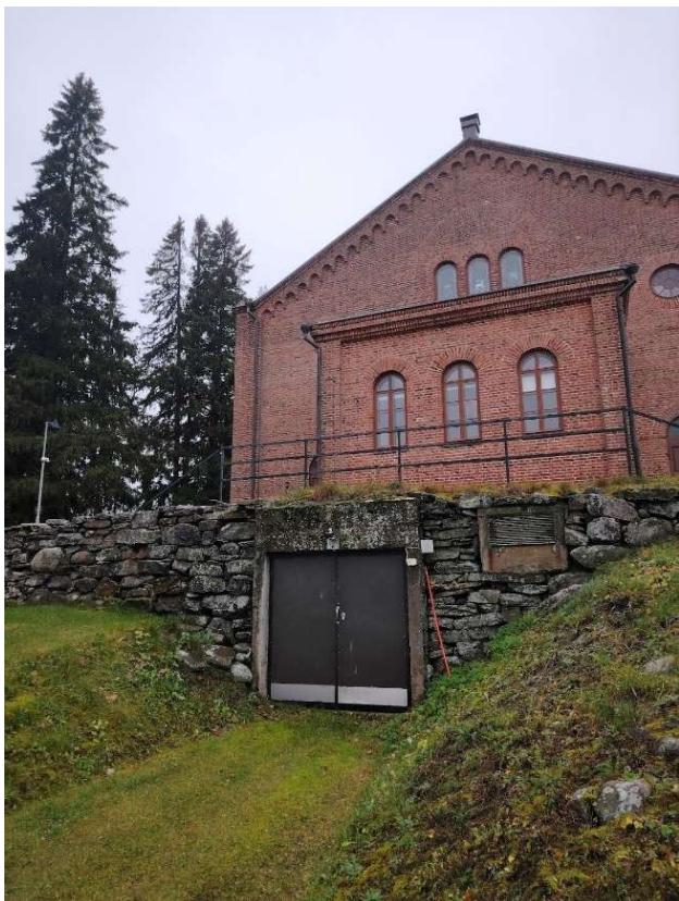
Lämmönjakuhuone on kirkon takana olevassa maapenkereessä, jossa on ollut aikoinaan viinikellari
