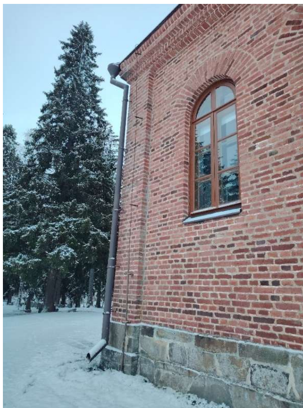
Sadevedet ohjautuvat katolta räystäskourujen kautta syöksyputkiin.
