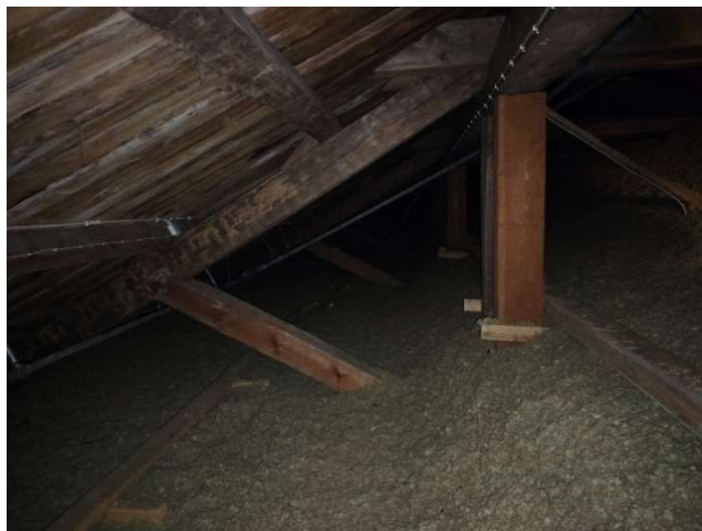
Välikatto lämpöeristettiin 1972. Vuonna 1999 tehtiin lisälämmöneristys puhallusvillalla.
