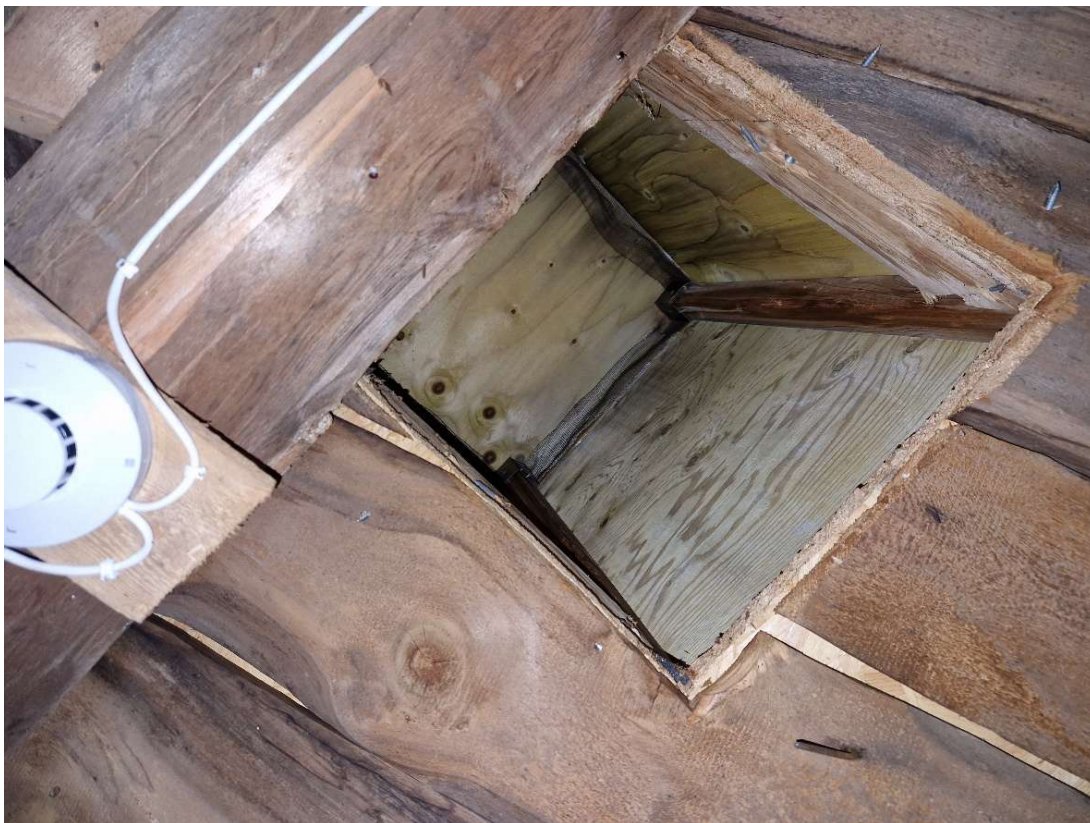
Yläpohjatilan tuulestusta on tehostettu rakentamalla harjalle tuuletusaukko. Rakennettu mahdollisesti edellisen vesikattoremontin yhteydessä vuonna 2011.
