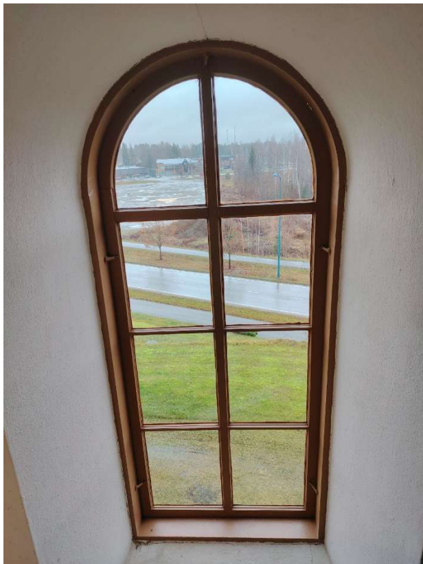
Vuonna 2025 kunnostettu porraskäytävän ikkuna.
