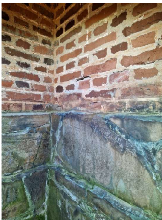
Sekä luonnonkivisokkelin, että tiiliseinän saumoja on korjailtu vuosien mittaan.
