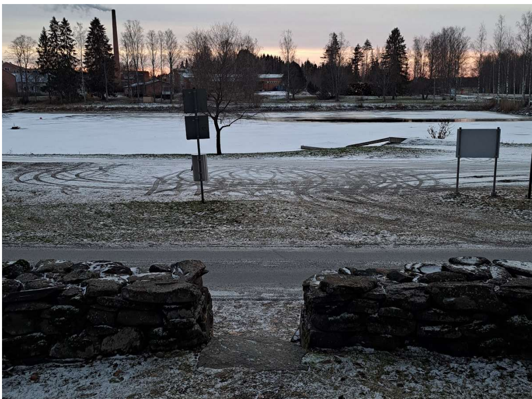
Kiviaidassa on kulkuväylä rantamakasiinille. Osa kiviaidan kulkuaukoista on tehty mahdollisesti aidan kunnostuksen yhteydessä.
