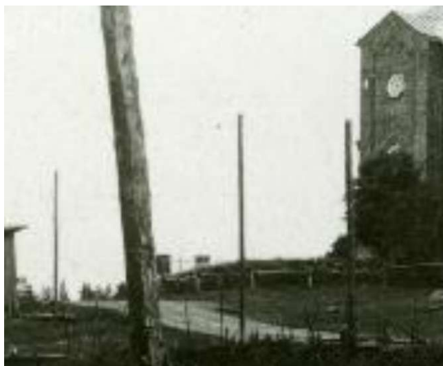
Myös sakastin puoleisella sivustalla oli portti. Lähde: Seurakuntain keskinäinen palovakuutusyhtiö, Elka.
