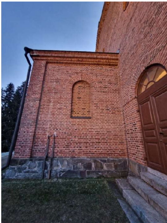
Sakastin vastakkaiset ikkuna-aukot ovat jossain vaiheessa muurattu umpeen.
