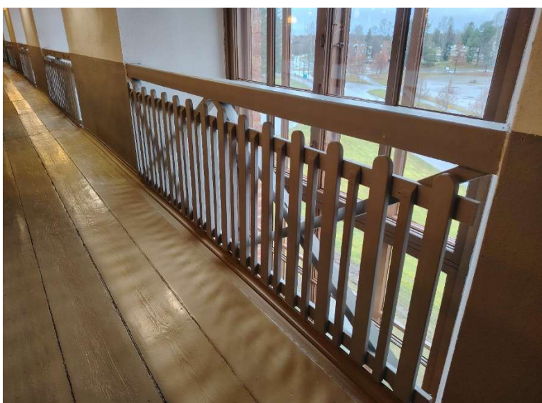
Lehtereiden ikkunasyvennysten kaiteiden turvallisuutta on parannettu suojaristikoilla, joka on kiinnitetty olemassa olleeseen kaiteeseen.
