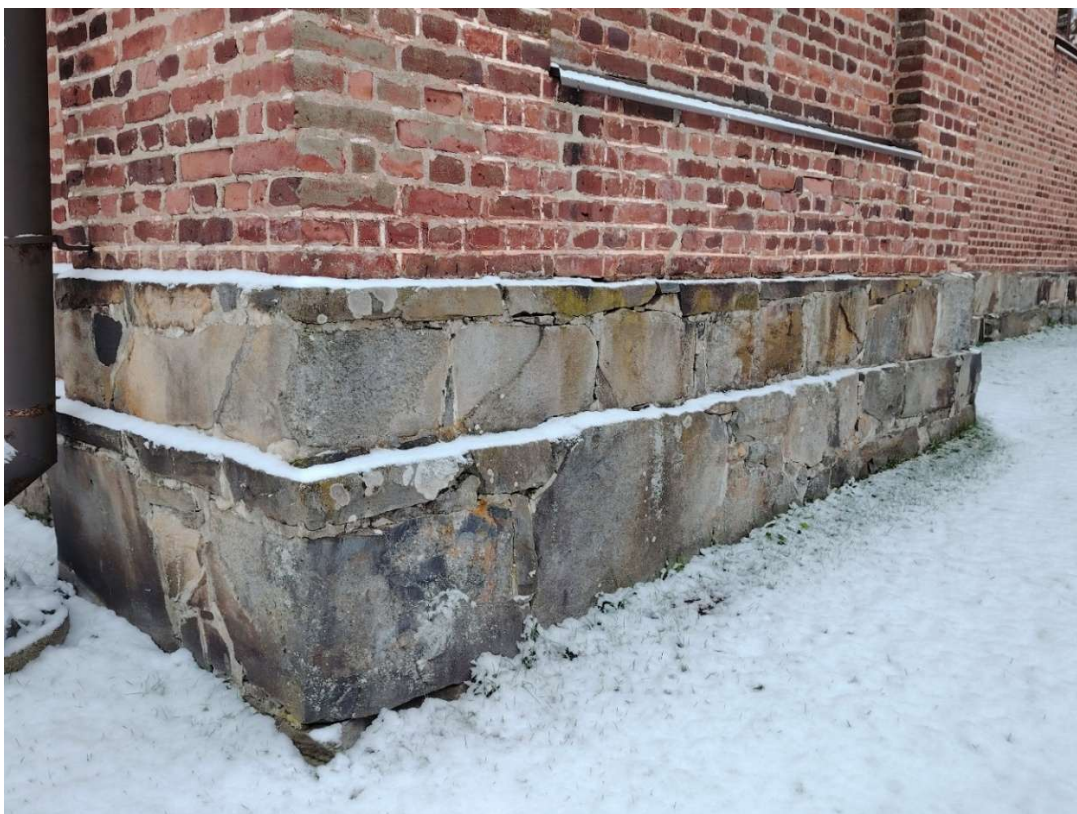
Luonnonkivistä muurattu perusmuuri.
