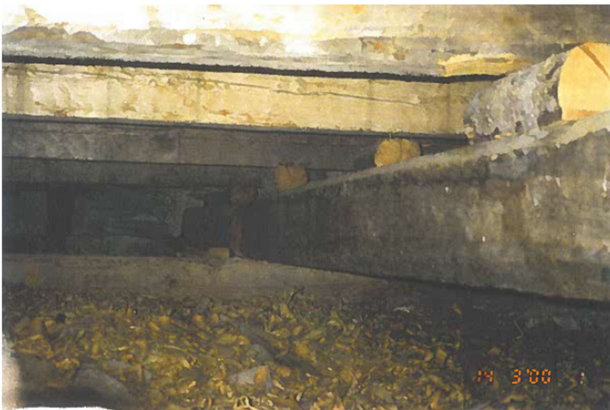
Kirkon ryömintätila kuvattuna vuonna 2000 tehdyn kuntotutkimuksen yhteydessä. Kuvaajat: Asko Ahikainen ja Jussi Kähkönen.
