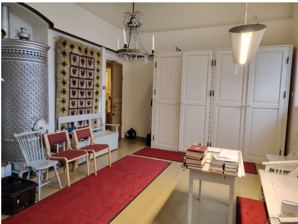
Kassakaappi ja sähkökeskus piilotettiin uusien kaappien sisään.
